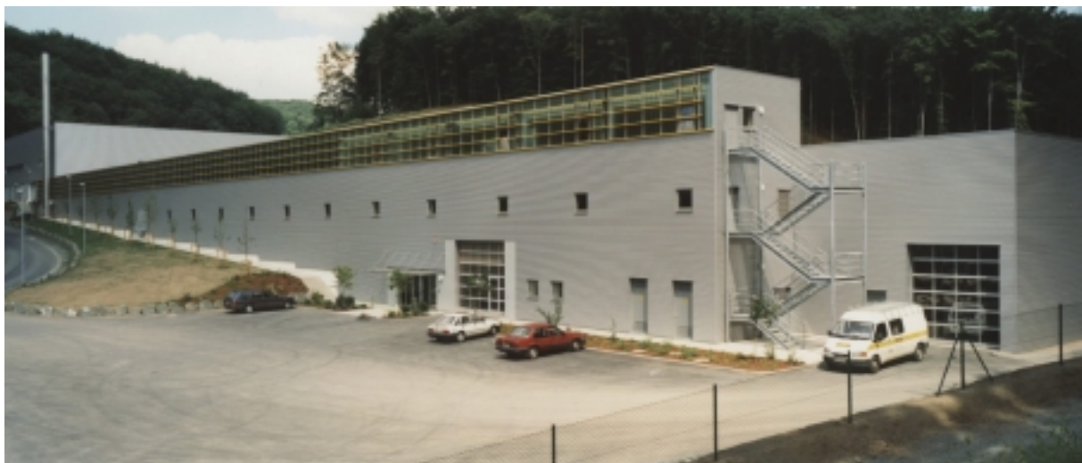
Abbildung 1: Außenansicht der Anlage der Fa. Herhof in Aßlar [9]
